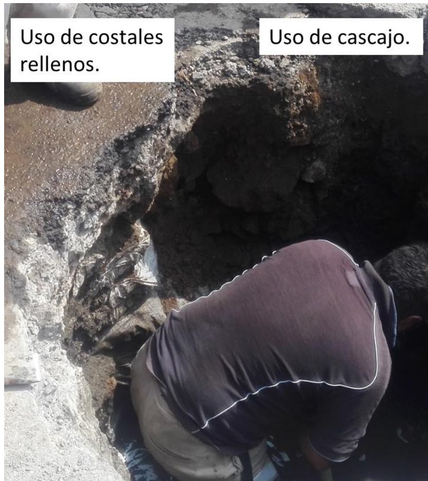
Figura 16. Materiales utilizados en el relleno de zona de hundimientos.
