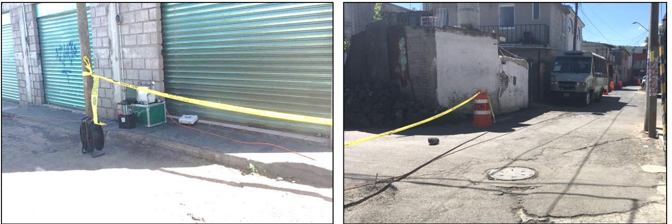
Figura 10. Fotografías donde se observan electrodos colocados en contacto con el terreno (19.2590° N, 99.03617° W. Calle: Cuauhtémoc).
