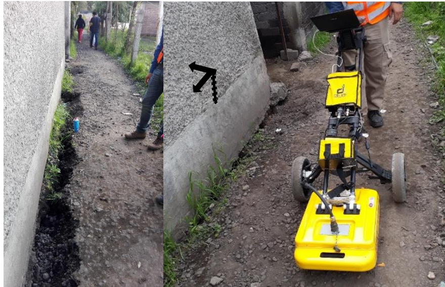
Figura # 3.6. Construcción habitacional en la zona norte de San Gregorio, Delegación Xochimilco. La estructura, aunque no sufrió daños significativos, el desplazamiento asociado a una sutil subsidencia desplazo a ésta en las direcciones correspondientes a los sistemas de fracturamiento A y B. El hundimiento es de 10 a 12 cm y con una inclinación de 70° hacia el NW.
