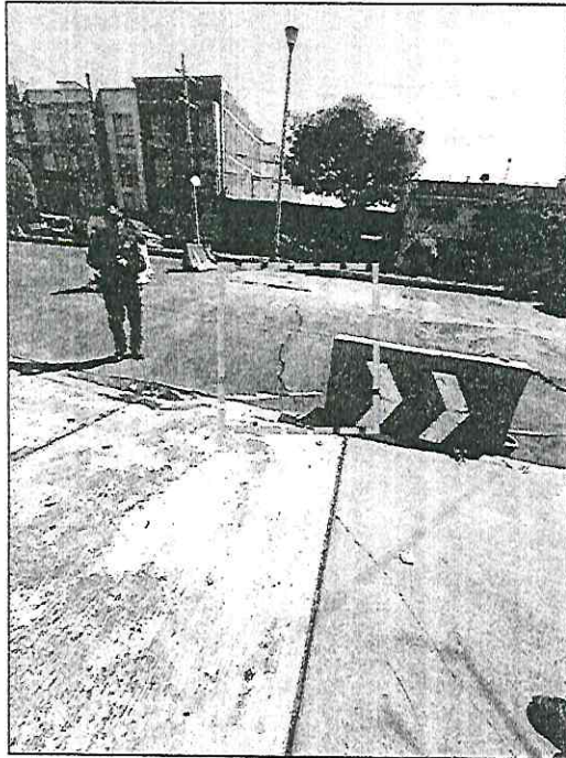
Figura 5. Agrietamiento en la carpeta asfáltica.
