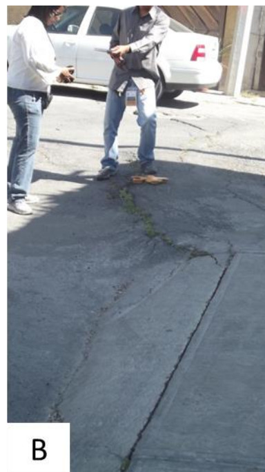
Figura 7. Fotografías que muestran el desplazamiento vertical y los daños causados por el mismo cercano al drenaje, fotografía A. Las dimensiones del desplazamiento vertical se observan en la fotografía B (19.2908° N; 99.0615° W. Calle: Océano).
