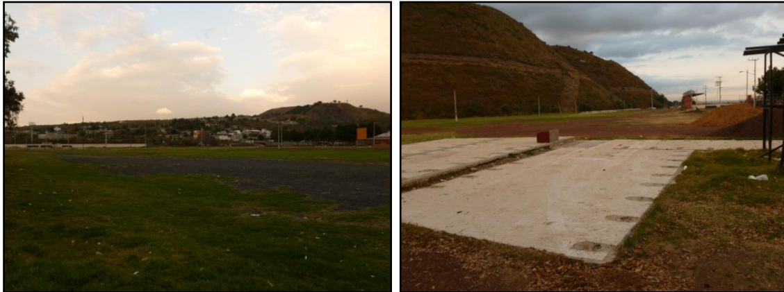
Fotografía 36 y 37. Instalaciones del deportivo Momoxco, embestido por el fenómeno de inundación.
