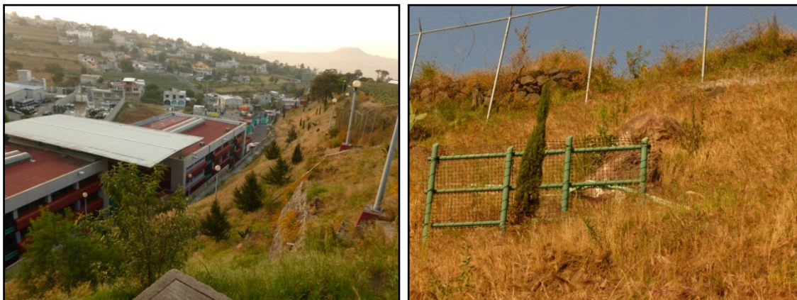
Fotografía 10 y 11. Susceptibilidad por caída de roca en la escuela preparatoria del poblado Santa Ana Tlacotenco.
