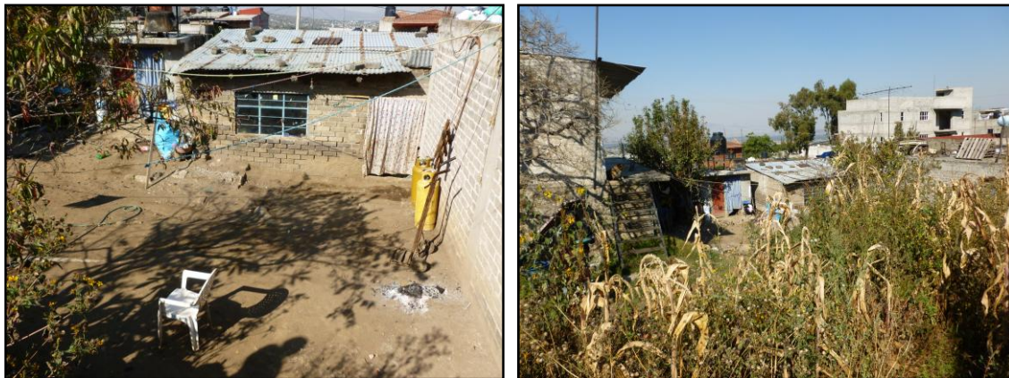
Fotografía 42 y 43. Viviendas en peligro de inundación por escorrentías
