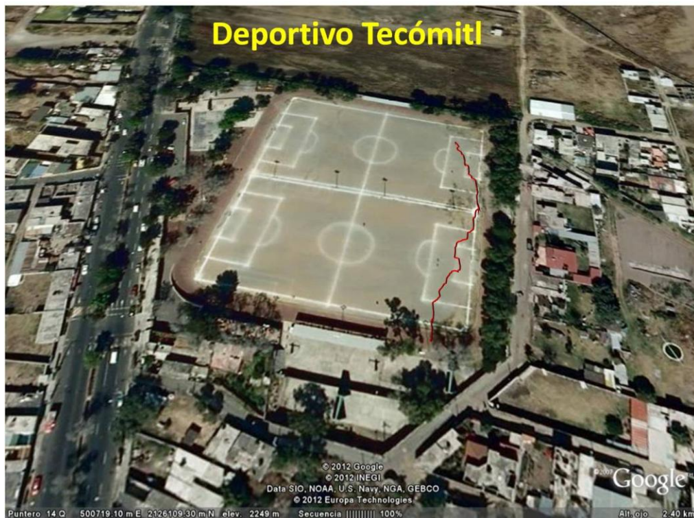
Figura 50. Simulación de la grieta la cual se forma en temporada de lluvias en el campo del deportivo Tecómitl.
