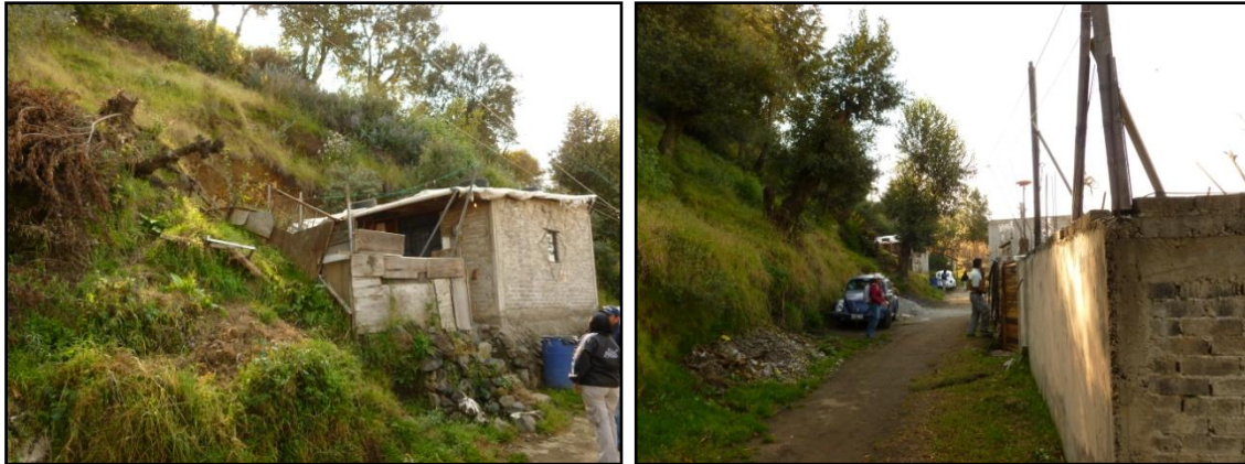
Fotografía 4 y 5. Susceptibilidad por inestabilidad de talud que afecta viviendas del poblado San Salvador Cuahtenco
