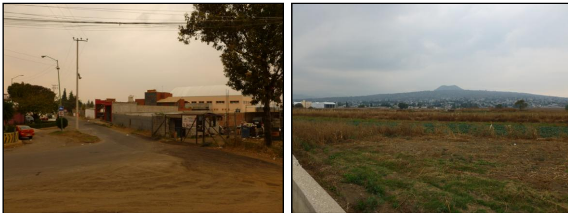
Fotografía 40 y 41. Inundación en el poblado San Antonio Tecómitl, afecta viviendas que se encuentran en la parte baja de la zona
