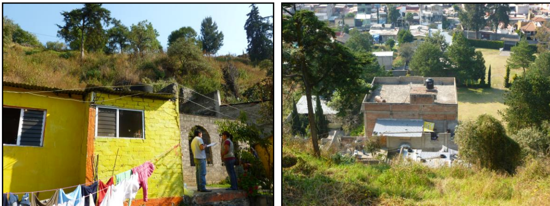
Fotografía 14 y 15. Viviendas afectadas que se encuentran cerca de la ladera
