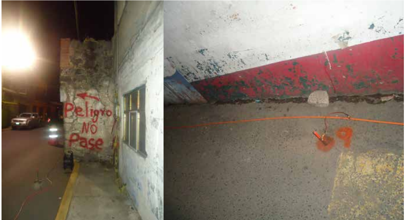
Figura 11. Fotografías donde se observan electrodos colocados en contacto con el terreno (19.215824° N, 98.994801° W. Calle: Guadalupe Victoria).
