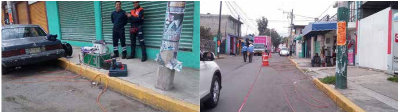
Figura 12. Fotografías donde se observan electrodos colocados en contacto con el terreno (19.208708° N, 99.067013° W. Calle: Francisco I. Madero).
