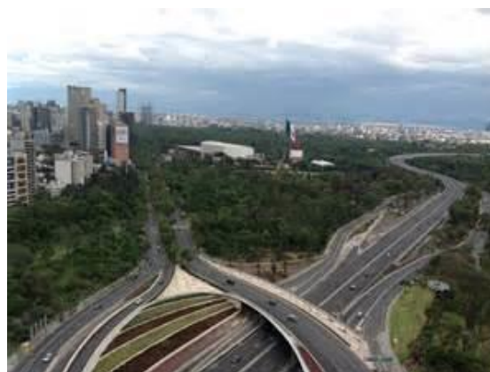
Toma del Anillo Periférico
