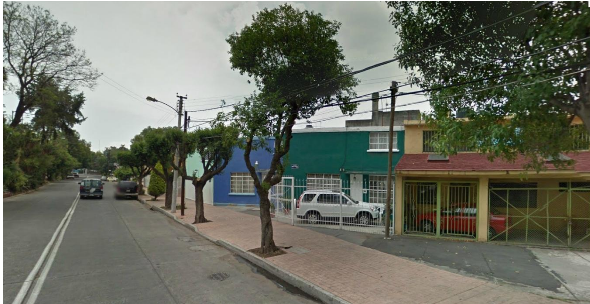
Figura 25. Vista de Plan de Guadalupe y Antúnez, Col. Plutarco Elías Calles. Sitio de acumulación de azolve.
