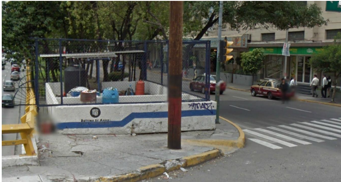
Figura 33. Vista de la Planta de bombeo de Calz. Melchor Ocampo y Marina Nacional, Col. Verónica Anzures.
