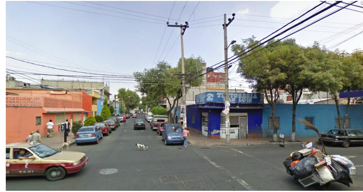
Figura 15. Vista de Lago Trasimeno y Lago Mask, Col. Anáhuac. Sitio de Insuficiencia de la red de drenaje y arrastre de materiales sólidos.
