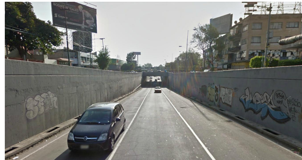
Figura 32. Vista del paso a desnivel de Avenida Parque Lira y Avenida Observatorio, Col. Tacubaya.
