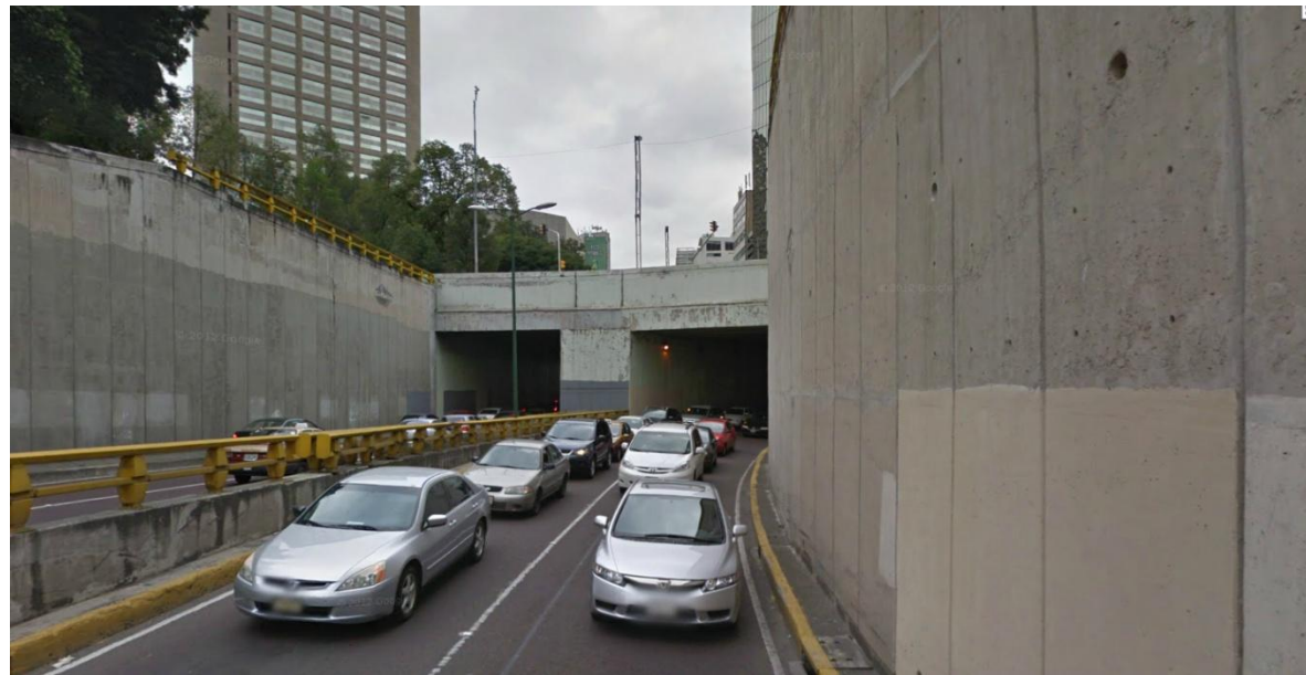
Figura 30. Vista del paso a desnivel de Av. Chivatito y Paseo de la Reforma, Col. Chapultepec.
