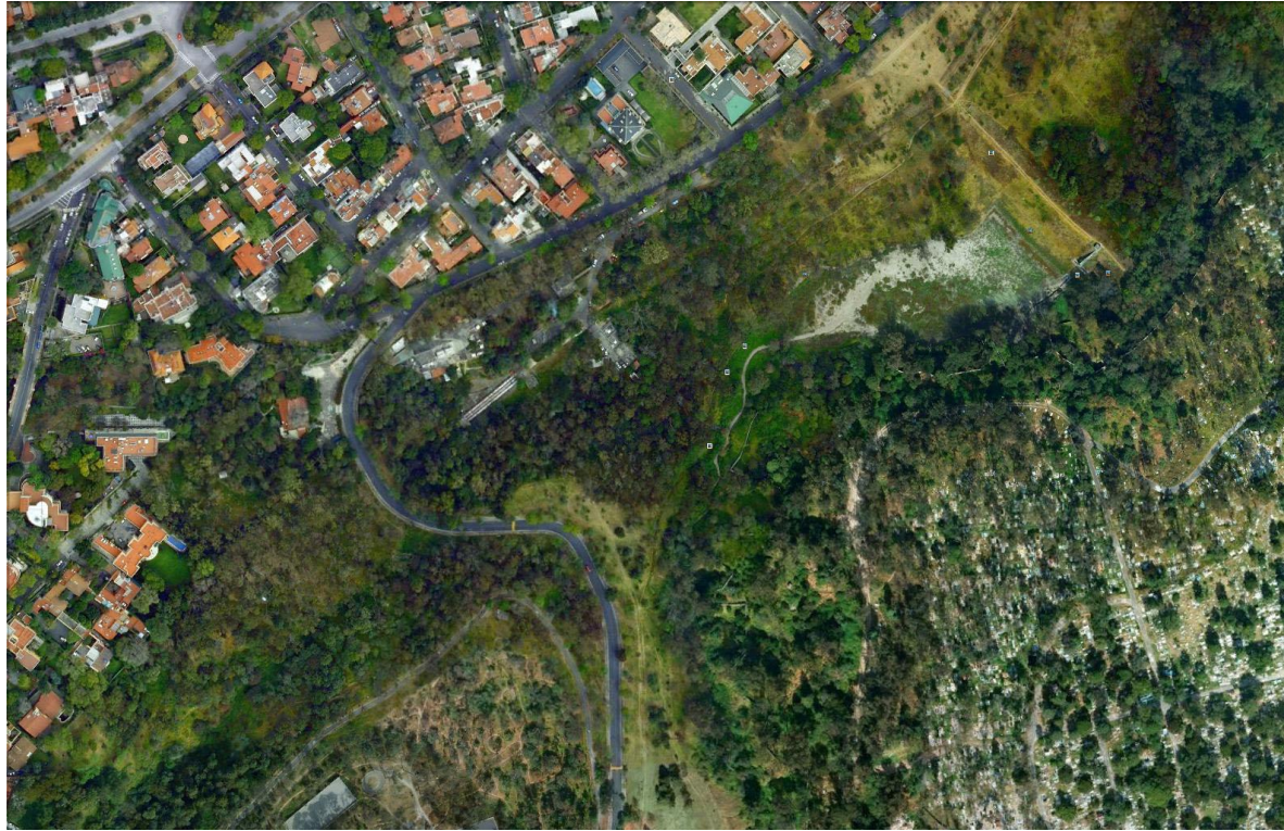
Figura 37. Vista en planta de la Presa Dolores.
