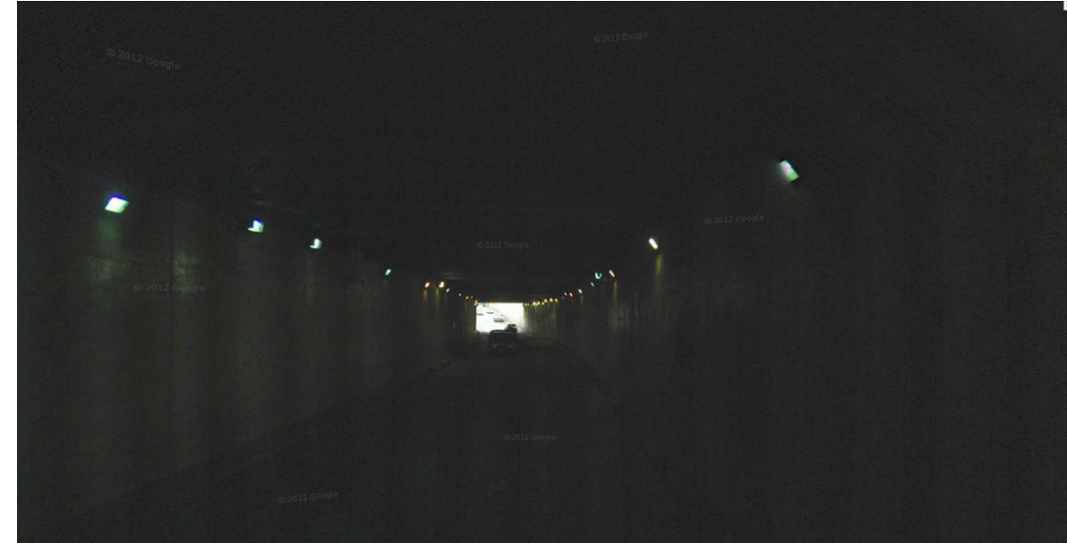
Figura 28.. Vista del paso a desnivel de Av. Constituyentes y Av. Pedro Antonio de los Santos, Col. San Miguel Chapultepec. (Interior)
