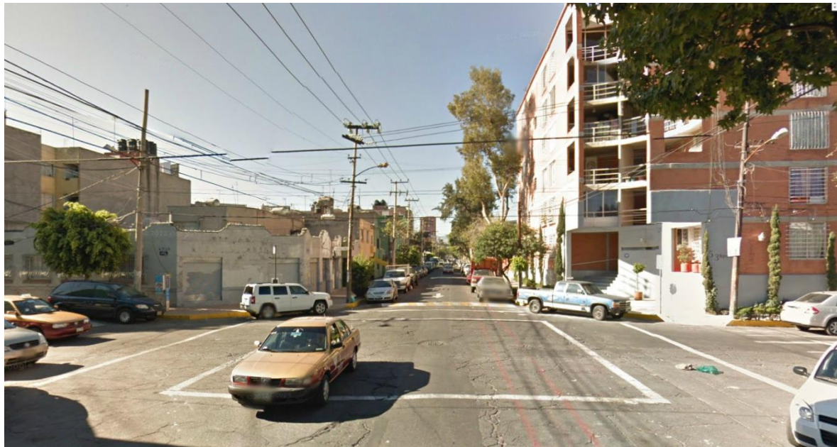
Figura 14. Vista de Quetzalcóatl y Nopaltzin, Col. Tlaxpana. Sitio de Insuficiencia de la red y accesorios pluviales.
