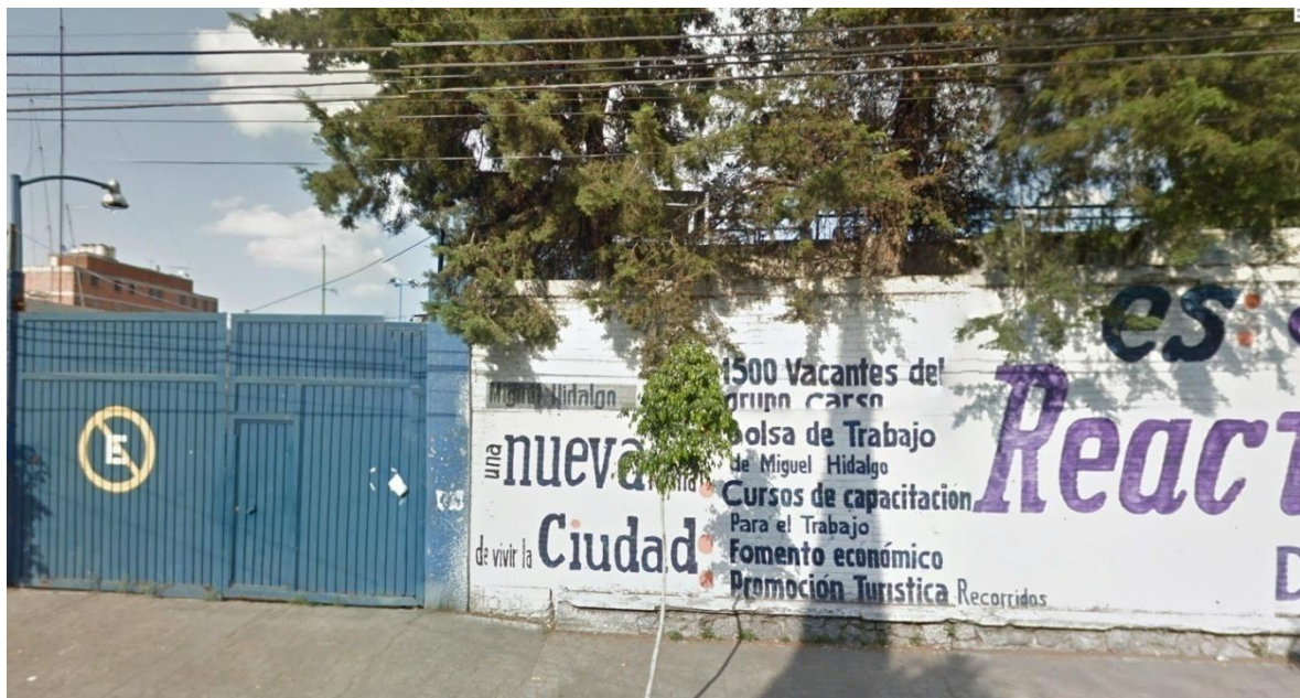
Figura 34. Vista de la Planta de bombeo de Tizoc y Tláloc, Col. Tlaxpána.
