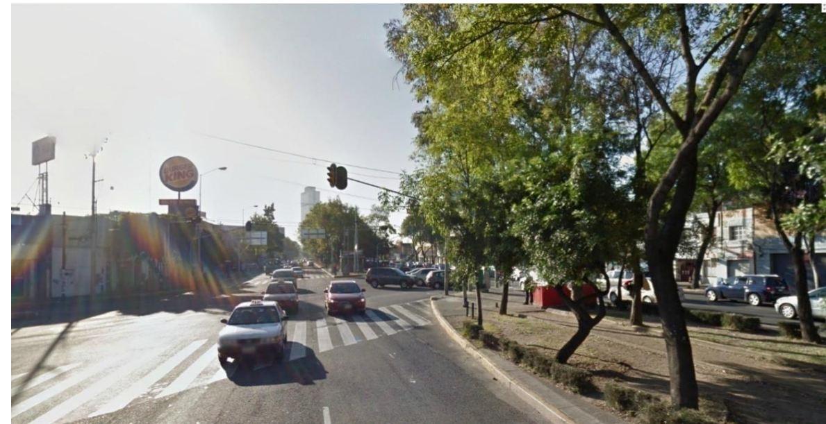
Figura 20. Vista de Marina Nacional y General Mariano Escobedo, Col. Anáhuac. Sitio de Insuficiencia de la red y accesorios pluviales.
