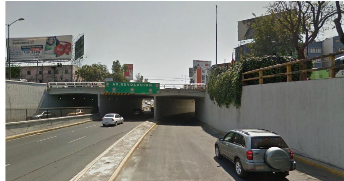
Figura 31. Vista del paso a desnivel de Viaducto Río la Piedad y Avenida Revolución, Col. Tacubaya.
