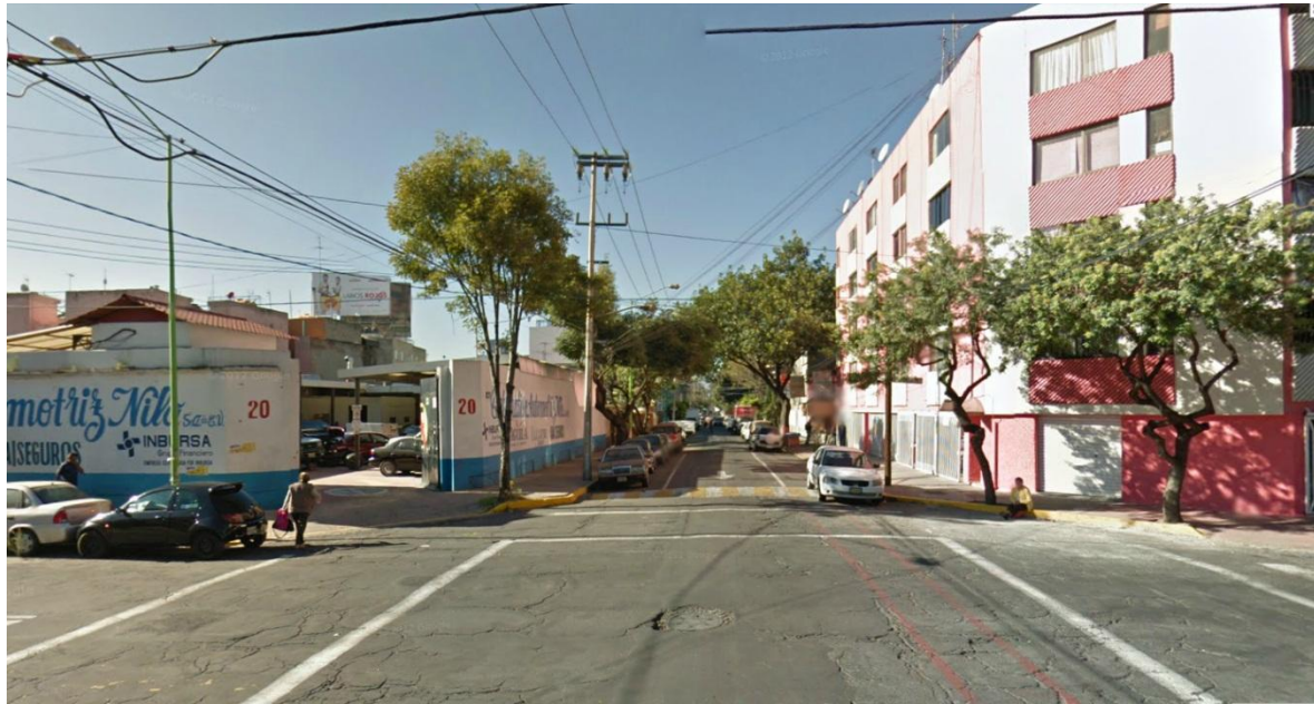
Figura 13. Vista de Quetzalcóatl y Xólotl, Col. Tlaxpana. Sitio de Insuficiencia de la red y accesorios pluviales.
