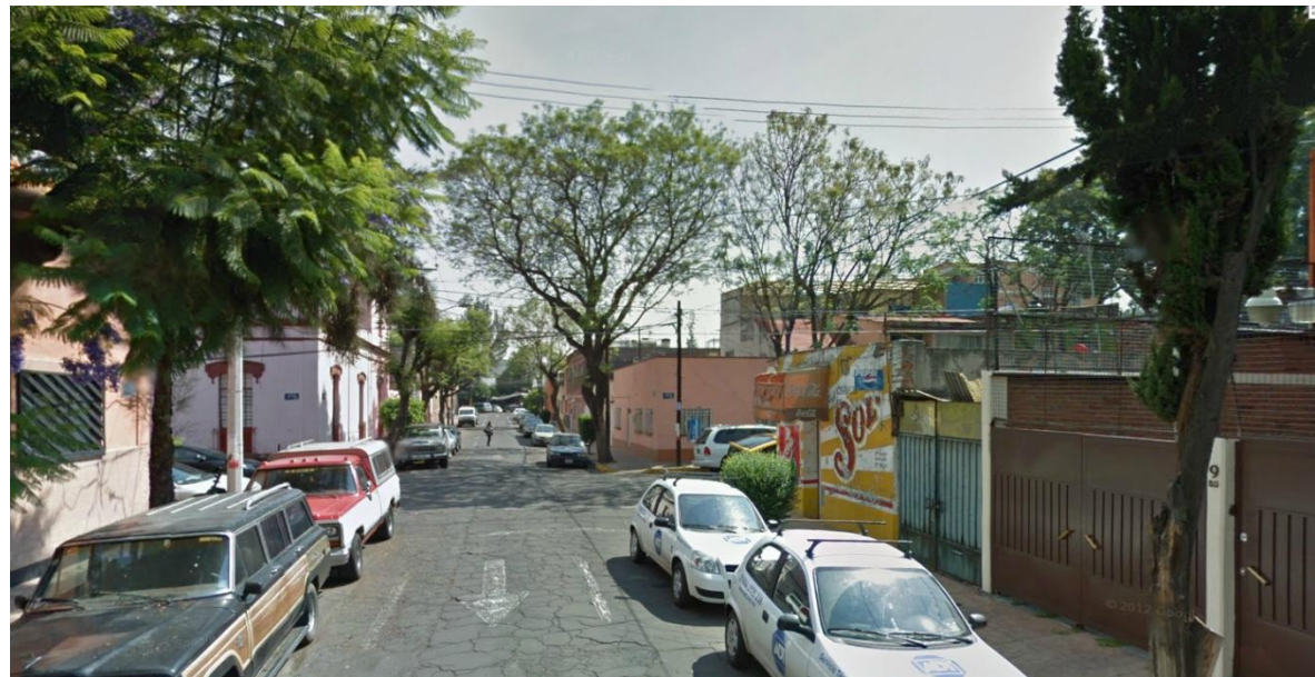
Figura 22. Vista de Mar Báltico y Mar Caspio, Col. Nextitla. Sitio de acumulación de azolve.
