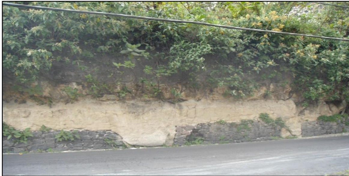
Ilustración 26. Calle en Lomas Altas donde se observa una ladera con material intemperizado.
