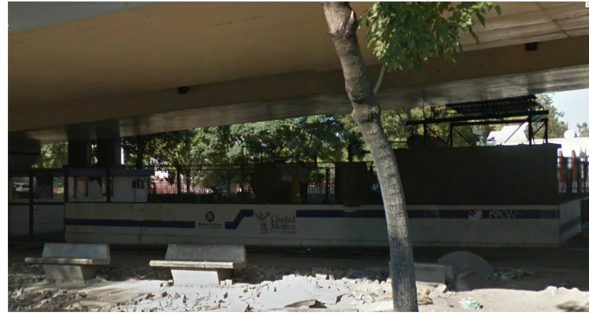
Figura 35. Vista de la Planta de bombeo "Politécnico" en Av. Inst. Técnico Industrial y Ricardo Flores Magón, Col. Santo Tomás.
