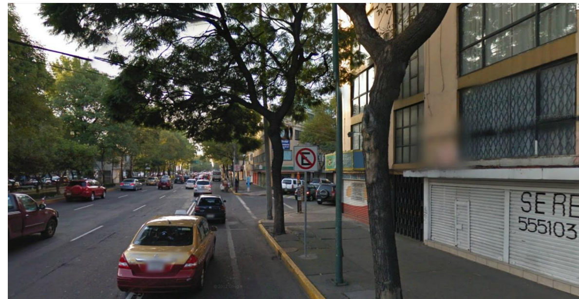
Figura 19. Vista de Marina Nacional y Lago Como, Col. Anáhuac. Sitio de Insuficiencia de la red y accesorios pluviales.
