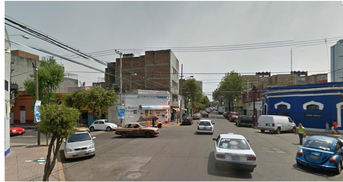
Figura 11. Vista de Av. Tláloc y Nopaltzín, Col. Tlaxpana. Sitio de Insuficiencia de la red y accesorios pluviales.
