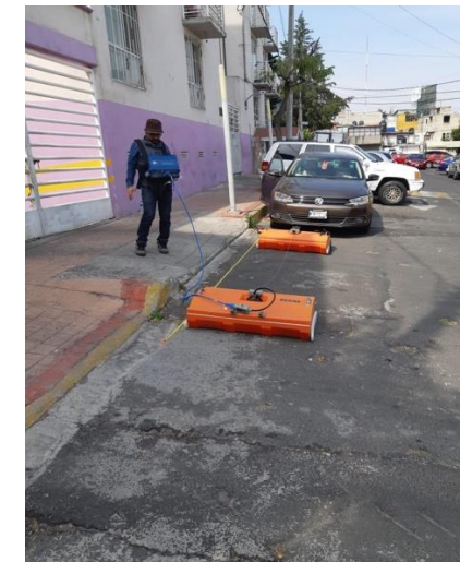
Figura 5. 9. Levantamientos de los sondeos CMP-1 y CMP-2, usando Radar de Penetración Terrestre (RPT) sobre la Calle Sur-130.
