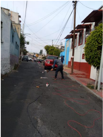
Figura 5. 5. Levantamiento del perfil de Dispersión de Ondas Sísmicas Superficiales (MASW) sobre la Calle Sur-130.
