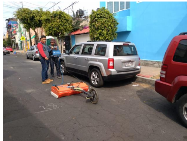
Figura 5. 7. Levantamiento del perfil de Radar de Penetración Terrestre (RPT) sobre la Calle Sur-130, usando antena de 100 MHz
