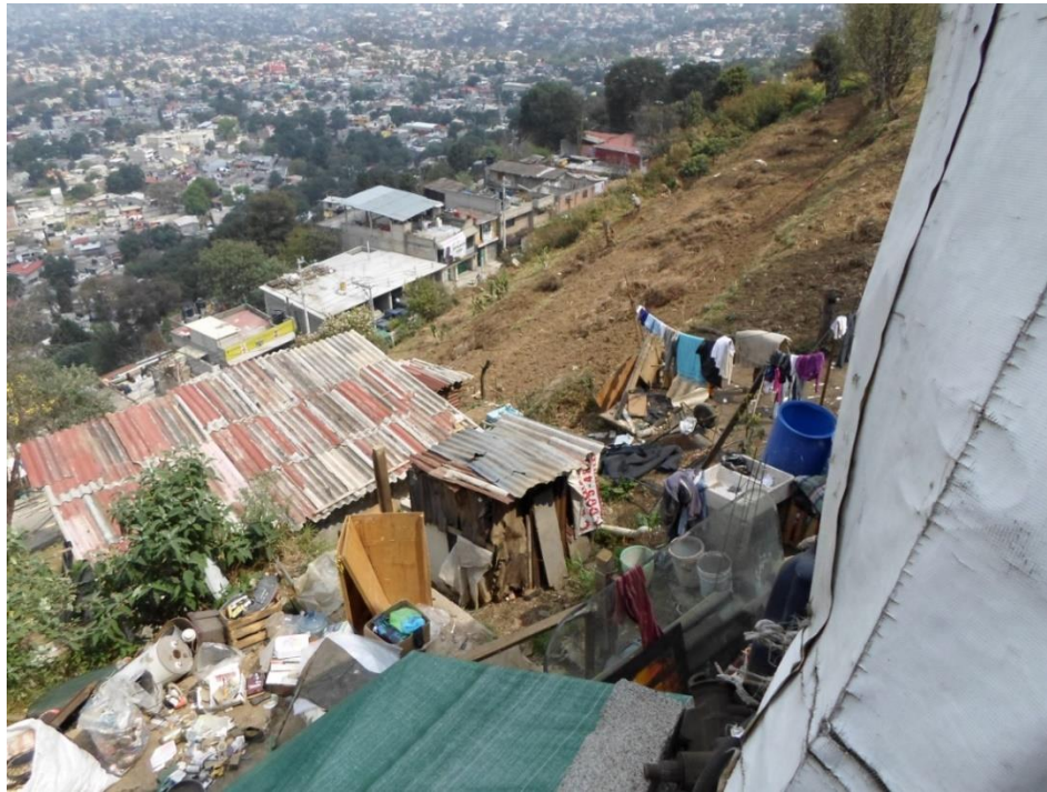
Figura 6. Construcciones rudimentarias desplantas sobre una ladera, propensa a arrastre de materiales, esto es notable por la presencia de erosión en el área circundante a la vivienda (19.2704° N, 99.2455° W. Calle: Jacarandas).
