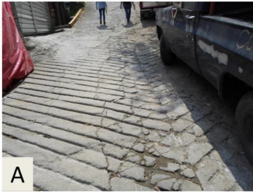
Figura 4. Recorrido realizado sobre la calle Jacarandas, se muestran grietas en la calle y materiales provenientes ladera arriba a un costado de la calle (19.2707° N, 99.2457° W. Calle: Jacarandas).
