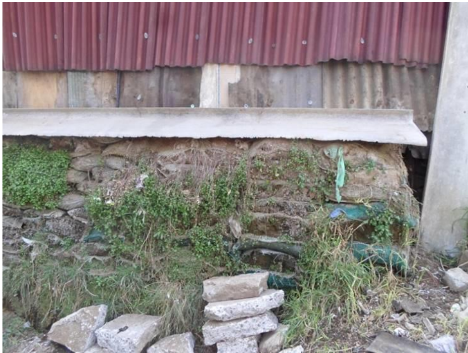
Figura 5. Construcción rudimentaria con obras de mitigación a base de costales rellenos, deterioradas a causa del intemperismo; se observa un pestaño hecho de concreto para protección de costales rellenos desviando el agua pluvial (19.2698° N, 99.2454° W. Calle: Azucena).
