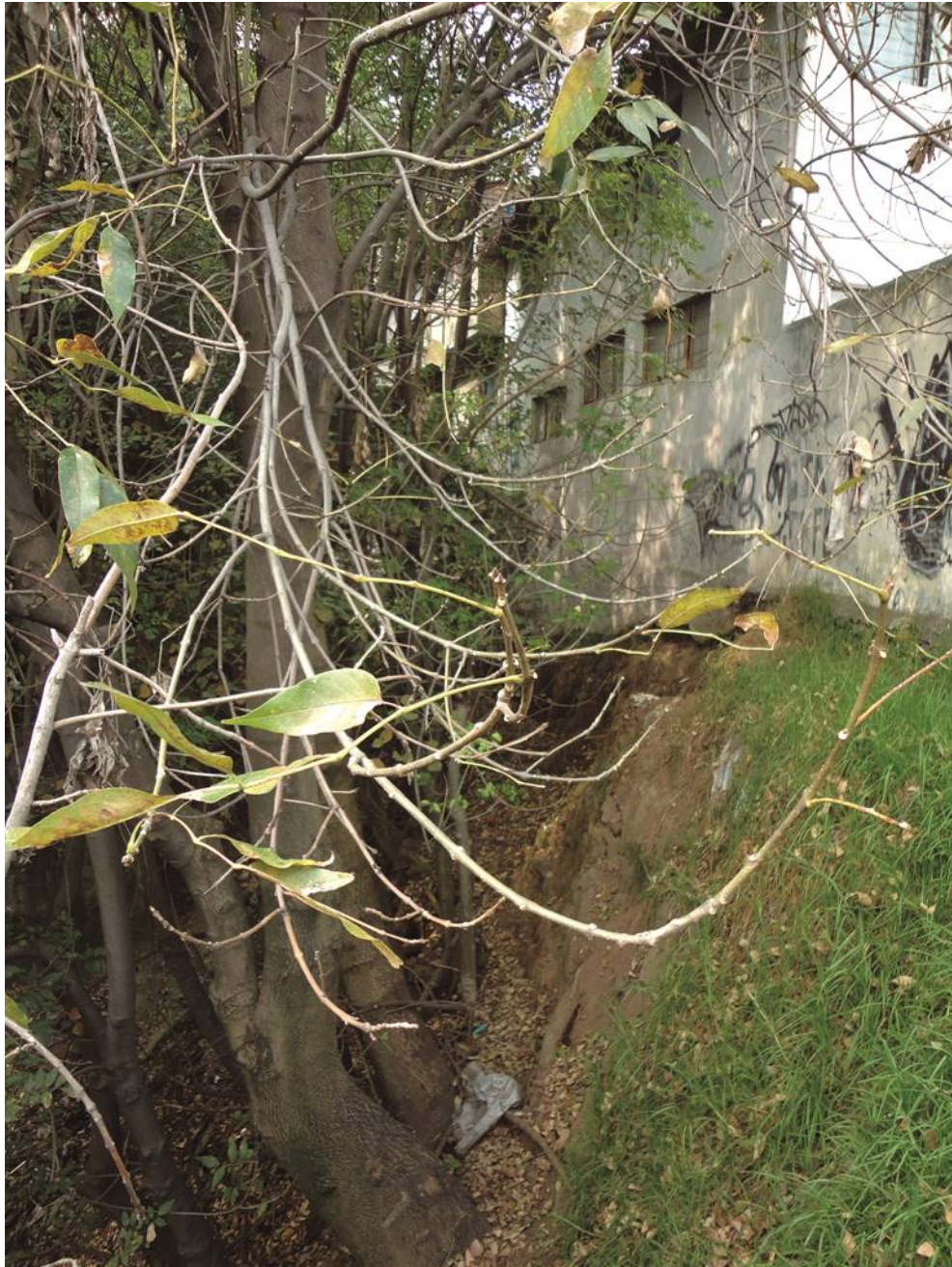
Figura 7. Construcción a orillas de una barranca donde se presenta pérdida de material a causa del intemperismo, esto es notable en la falta de vegetación en la pared de talud y la exposición las raíces de los árboles cercanos (19.3161° N, 99.2530° W: Calle: Sin nombre oficial, colonia Atacaxco).
