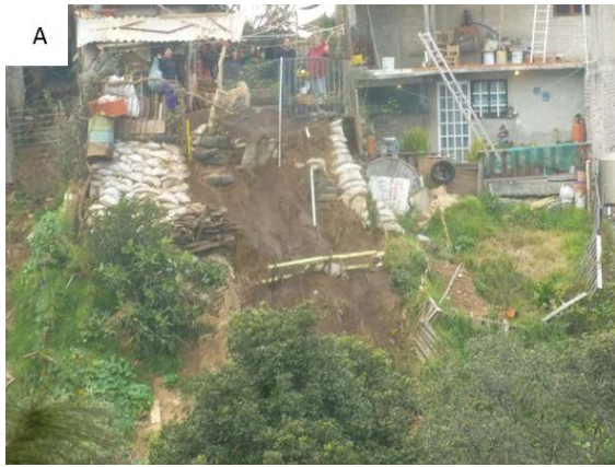
Figura 25. A) Se observa el fenómeno de erosión superficial acelerado por el agua que desecha la vivienda y que afecta al muro de contención y erosiona los materiales de la Capa 2 (en la vivienda afectada se ven los materiales muy saturados en agua, lo que no se ve en las viviendas vecinas). B) Se muestra en una de las obras la combinación de muros confinados en la base y gaviones en la parte superior, estos últimos detienen los suelos y filtran el agua. La obra carece de altura para detener el movimiento de los materiales por encima de la misma, el cual es evidente por la inclinación de los árboles.
