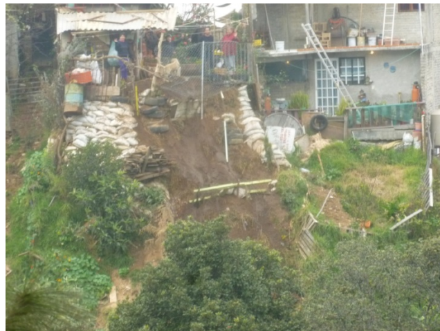
Figura 6. Se muestra el uso de costales rellenos apilados como muro de contención para detener el movimiento del terreno, lo cual es sólo una solución temporal. En la fotografía también se muestra la disposición hidrosanitaria sobre el talud de la barranca (19.3026° N; 99.2599° W. Calle Temamatla).
