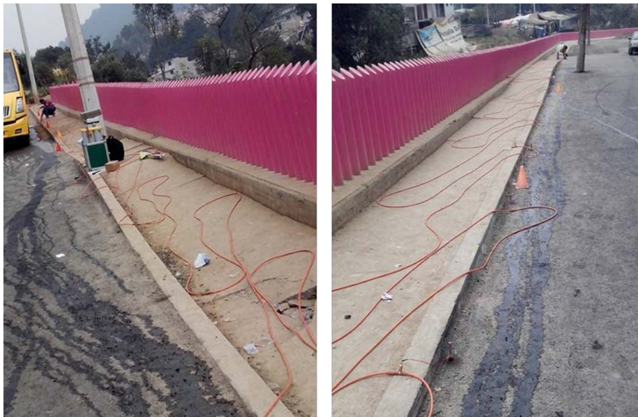
Figura 12. Fotografías que muestran el tendido del cable y electrodos durante el levantamiento (19.3042° N; 99.2592° W. Calle: Coconetla).
