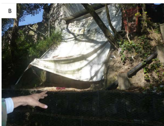
Figura 24. A) Esquema que muestra derrumbes y deslizamientos de materiales de los cimientos de las viviendas (cascajo) y de los que componen la Capa 2, provocados por el flujo de agua subterráneo y el flujo de aguas negras superficial proveniente de las construcciones. B) Fotografía de una lona con la que se trata de disminuir la erosión superficial de los materiales, pero se olvidan de la erosión provocada por el flujo subterráneo. C) Fotografía de un muro de contención con costales, que permite el flujo de agua y retiene el suelo, la desventaja es que se construye sobre materiales sin compactación.
