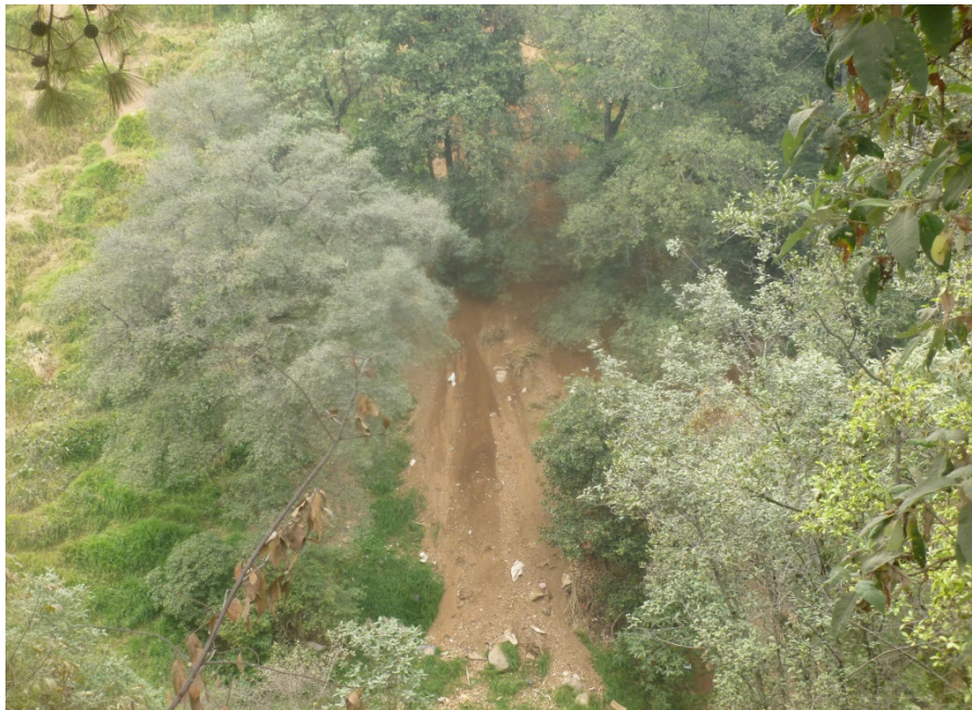
Figura 8. Derrumbe sobre una de las laderas de la barranca Coconetla (19.3020° N; 99.2601° W. Calle: Coconetla).
