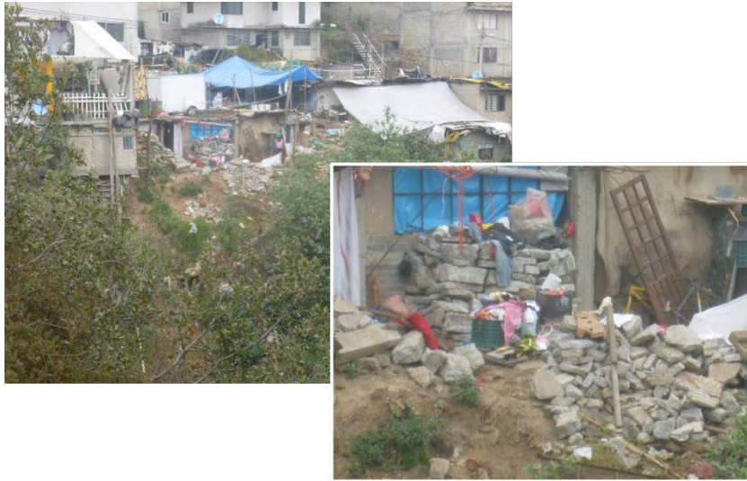
Figura 5. Se muestra la parte posterior de las viviendas que se encuentran en la calle Temamatla que están expuestas al peligro de derrumbes y deslizamiento de los materiales que componen el suelo sobre el que construyeron sus viviendas y como una forma de querer disminuir esos fenómenos han construido muros de contención improvisados de cascajo o roca acomodada (19.3035° N; 99.2595° W. Calle: Temamatla).
