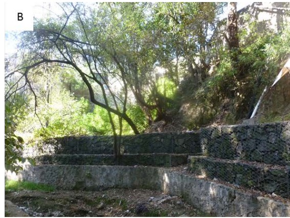
Figura 25. A) Se observa el fenómeno de erosión superficial acelerado por el agua que desecha la vivienda y que afecta al muro de contención y erosiona los materiales de la Capa 2 (en la vivienda afectada se ven los materiales muy saturados en agua, lo que no se ve en las viviendas vecinas). B) Se muestra en una de las obras la combinación de muros confinados en la base y gaviones en la parte superior, estos últimos detienen los suelos y filtran el agua. La obra carece de altura para detener el movimiento de los materiales por encima de la misma, el cual es evidente por la inclinación de los árboles.
