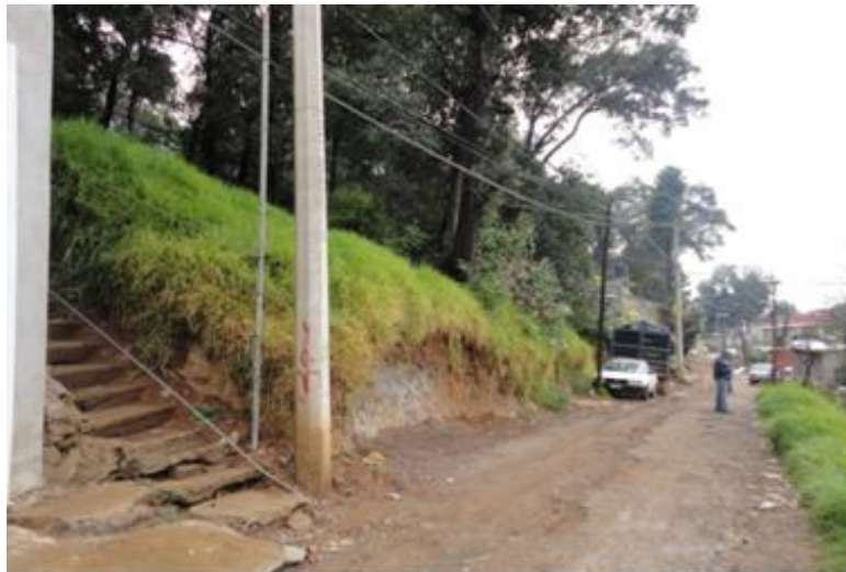
Pequeños cortes llegan a inducir caída de material y reptaciones de la ladera, la cual se manifiesta por la inclinación de árboles.
