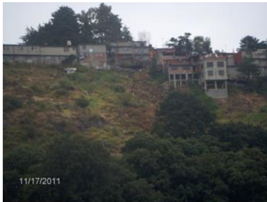
Se observa el modo de construir las viviendas, ganándole terreno a la ladera, no a través de cortes sino cimentando a través de columnas y muros.
