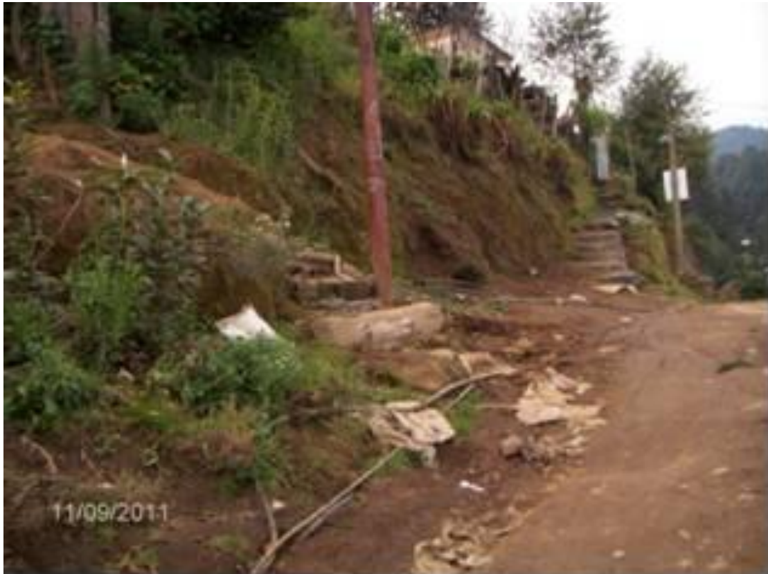
Obsérvense las viviendas en el hombro del talud con cortes verticales con evidencias de deslizamientos.
