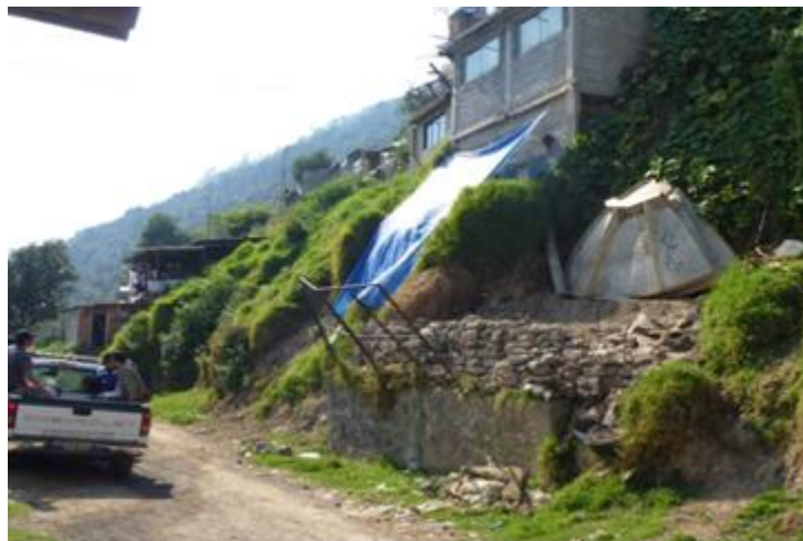
La actividad antrópica provoca la paulatina deforestación de las laderas. Se observa la evidencia de un deslizamiento cubierto con plástico.
