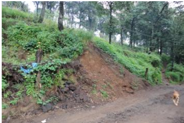
Deslizamiento de suelo, con señales de saturación de agua.
