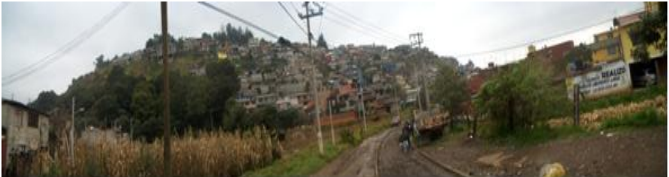
Panorámica general de la colonia el Chisto, como se puede observar las viviendas están distribuidas a lo largo y alto de toda la ladera.
