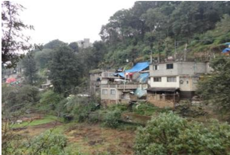
Viviendas de 2 a 3 niveles ubicadas a la orilla del cauce, algunas de ellas se encuentran soportadas por costaleras.
