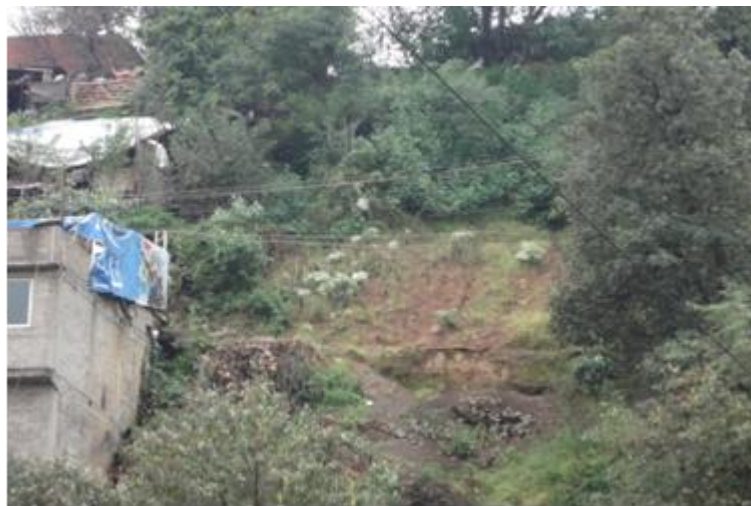
Deslizamiento ocurrido en la calle Nogal, el cual provocó el desalojo de personas por afectación a su vivienda.
