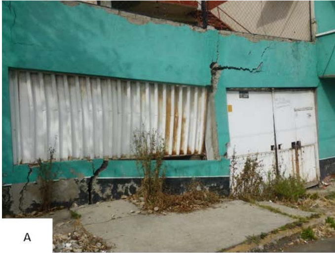
Figura 11. Fotografías de una vivienda con múltiples fallas en sus diferentes elementos constructivos: trabes, castillos y muros (fotografía A) asociadas al desplazamiento vertical que atraviesa la calle (fotografía B) (19.3684° N; 99.0141° W. Calle: Claudio Alcocer).
