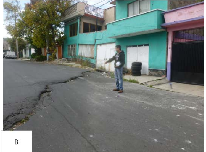
Figura 11. Fotografías de una vivienda con múltiples fallas en sus diferentes elementos constructivos: trabes, castillos y muros (fotografía A) asociadas al desplazamiento vertical que atraviesa la calle (fotografía B) (19.3684° N; 99.0141° W. Calle: Claudio Alcocer).
