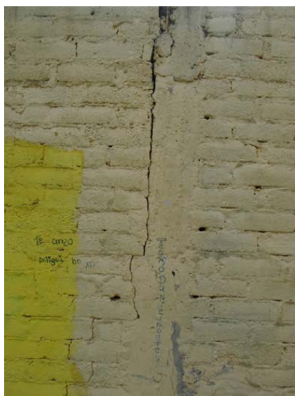
Figura 11. Fotografías que muestran una vivienda con fracturas en muros exteriores ( 19.3685^{\circ} N, 99.030^{\circ} W. Calle: Agustín Bolleto).
