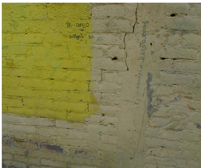
Figura 11. Fotografías que muestran una vivienda con fracturas en muros exteriores ( 19.3685^{\circ} N, 99.030^{\circ} W. Calle: Agustín Bolleto).
