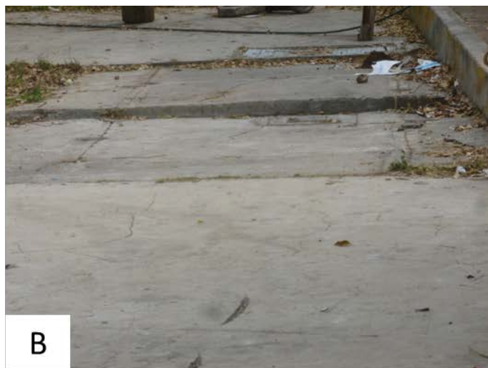
Figura 10. Fotografías tomadas en el parque (fotografía A) que muestran el hundimiento apreciable en las losas (fotografía B) que recubren el terreno ( 19.3717^{\circ} N, 99.0328^{\circ} W. Calle: Retorno 1 Legión del Norte).
