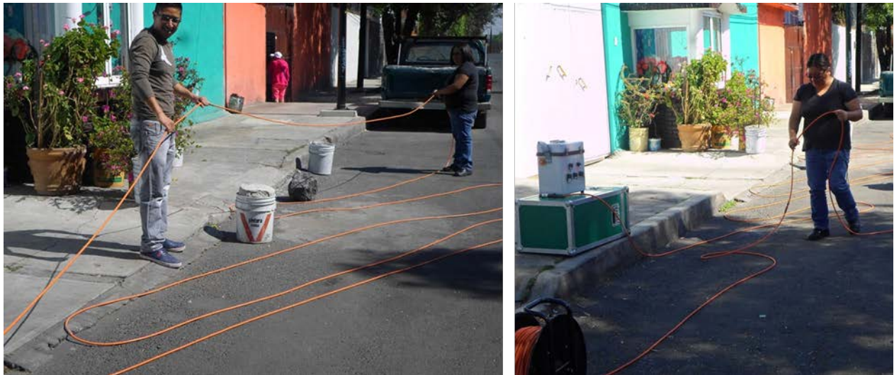
Figura 13. Fotografías que muestran el tendido del cable y el equipo durante el levantamiento (19.3447° N; 99.0421° W. Calle: Calle 45).
