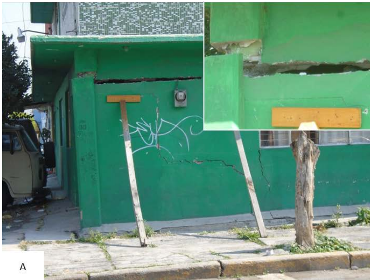
Figura 7. Viviendas afectadas en la zona del hundimiento. Imagen A, construcción con afectaciones en muro y en la estructura donde se desplazó el castillo en el amarre con la losa. Al parecer el castillo carece de varillas o no continúan en toda la sección longitudinal. Imagen B, vivienda con desprendimiento vertical en estructura de confinamiento (19.3445° N; 99.0425° W. Calle: Calle 47).
