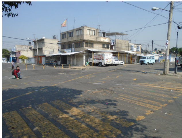
Figura 6. Zona de hundimiento en el cruce de vialidades, existe un letrero de peligro y paneles de prevención al tránsito vehicular (19.3445° N; 99.0425° W. Calle: Calle 47).
