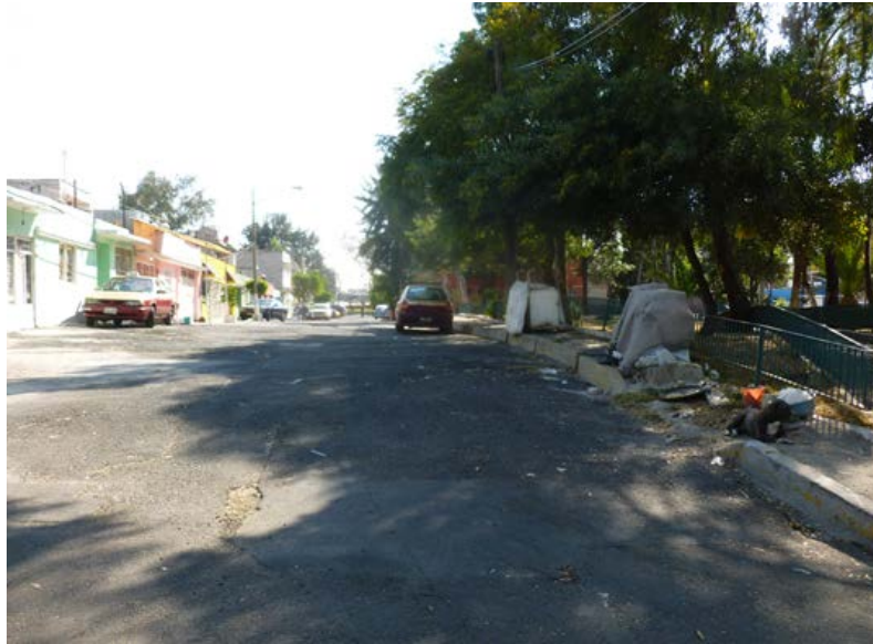
Figura 8. Fotografía del parque ubicado entre la Calle 49 y la Calle 51 con hundimientos diferenciales en la carpeta asfáltica de las vialidades que le rodean y en el terreno sobre el que se asienta (19.344227° N; 99.042907° W; Calle: Calle 49)
