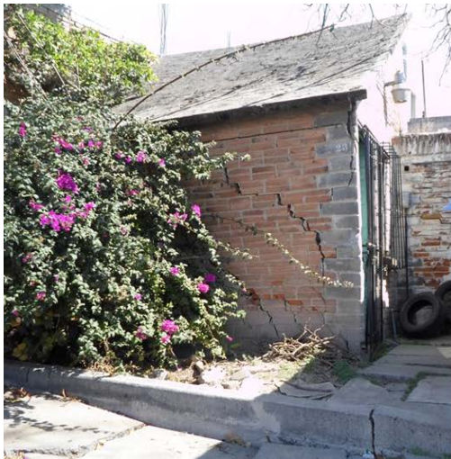
Figura 12. Fotografía que muestra un inmueble que sufre múltiples fracturas en forma diagonal y vertical. En campo se observó que por la parte inferior del inmueble pasa una fractura que se asocia a los daños estructurales. La fachada de la vivienda presenta una fractura en la esquina y en la parte inferior de la losa, estas fracturas también pudieron ser ocasionadas porque la vivienda no tiene un buen confinamiento (19.3624° N, - 98.9977° W. Calles: Dionisio Rojas y Niño Artillero).
