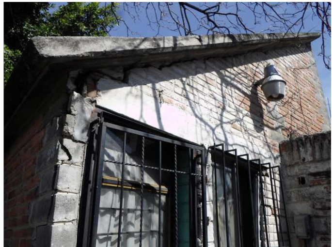
Figura 12. Fotografía que muestra un inmueble que sufre múltiples fracturas en forma diagonal y vertical. En campo se observó que por la parte inferior del inmueble pasa una fractura que se asocia a los daños estructurales. La fachada de la vivienda presenta una fractura en la esquina y en la parte inferior de la losa, estas fracturas también pudieron ser ocasionadas porque la vivienda no tiene un buen confinamiento (19.3624° N, - 98.9977° W. Calles: Dionisio Rojas y Niño Artillero).
