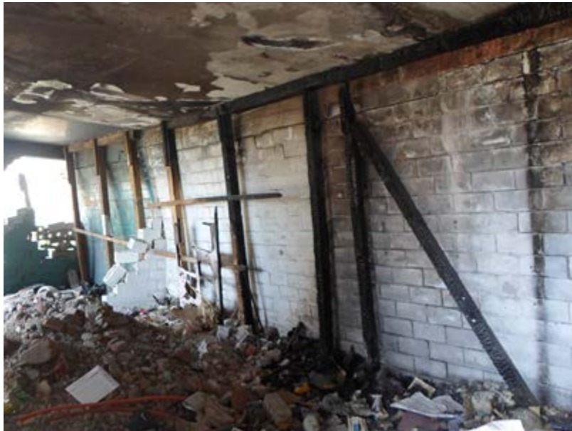
Figura 9. Fotografía que muestra una vivienda en la que se usaron puntales (que tienen la función de transmitir las cargas de la losa hacia el suelo) y vigas de madera (que sostienen las cargas de la losa del entrespiso); pese a las obras de mitigación la estructura del inmueble falló (19.3626° N, 98.9983° W. Calles: Anselmo de Adán y Niño Artillero).
