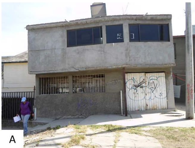
Figura 10. Fotografías de un inmueble donde se observan un mayor hundimiento en la parte izquierda (Fotografía A), fracturas horizontales en los muros, desprendimiento del acabado en la parte de la losa y un puntal de acero que funciona como una columna para soportar las cargas estructurales (Fotografía B) (19.3626° N, 98.9983° W. Calles: Anselmo de Adán y Niño Artillero).
