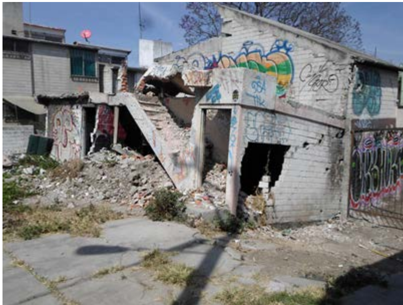
Figura 8. Fotografía que muestra una edificación que presenta colapsos parciales debido a que la zona presenta un hundimiento local que ocasionó que la vivienda sufriera múltiples fracturas diagonales en muros y que los diferentes elementos estructurales fallaran (19.3626° N, 98.9983° W. Calles: Anselmo de Adán y Niño Artillero).
