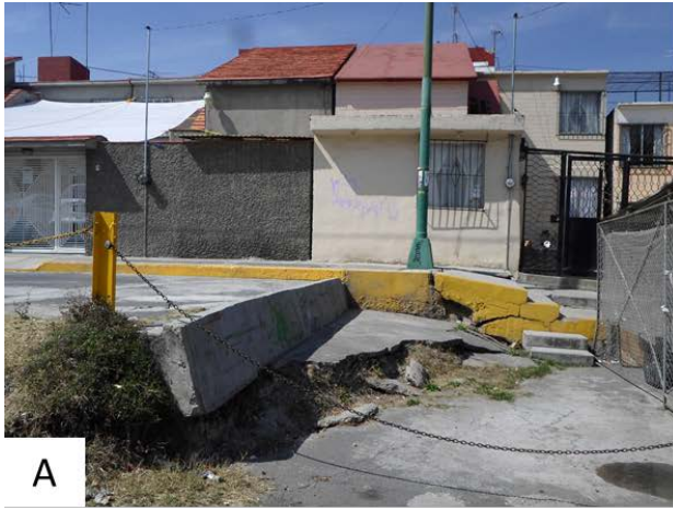
Figura 11. Fotografías que muestran el hundimiento y su afectación a la vialidad, acera y estacionamiento. La Fotografía A muestra un cambio de nivel de aproximadamente 50 cm, por lo que se añadieron escalones. En el borde de la acera se ven fracturas de mayores dimensiones. La Fotografía B ilustra la prolongación del cambio de nivel en el área del estacionamiento, esto provocó una fractura que fue cubierta con carpeta asfáltica (19.3625° N, 98.9980° W. Calles: José Pagola y Niño Artillero).
