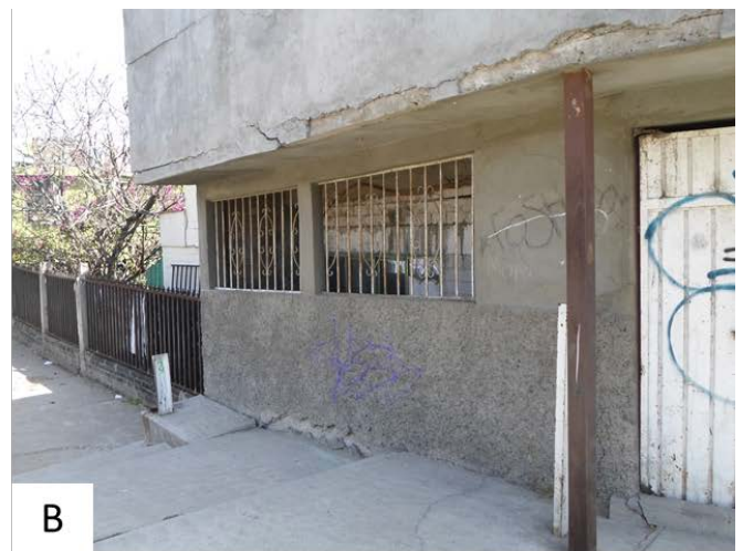
Figura 10. Fotografías de un inmueble donde se observan un mayor hundimiento en la parte izquierda (Fotografía A), fracturas horizontales en los muros, desprendimiento del acabado en la parte de la losa y un puntal de acero que funciona como una columna para soportar las cargas estructurales (Fotografía B) (19.3626° N, 98.9983° W. Calles: Anselmo de Adán y Niño Artillero).
