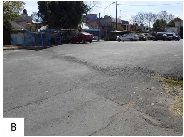
Figura 11. Fotografías que muestran el hundimiento y su afectación a la vialidad, acera y estacionamiento. La Fotografía A muestra un cambio de nivel de aproximadamente 50 cm, por lo que se añadieron escalones. En el borde de la acera se ven fracturas de mayores dimensiones. La Fotografía B ilustra la prolongación del cambio de nivel en el área del estacionamiento, esto provocó una fractura que fue cubierta con carpeta asfáltica (19.3625° N, 98.9980° W. Calles: José Pagola y Niño Artillero).
