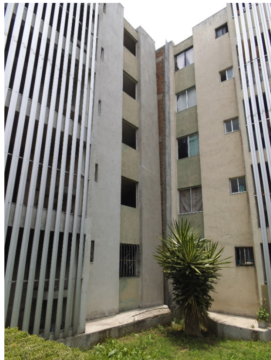
Figura 8. Edificios colindantes que presentan inclinación y separación desigual entre juntas constructivas. El grado de inclinación de las construcciones las ha hecho inhabitables (19.5084° N, 99.1563° W. Calle: S.C.T. esquina Telecomunicaciones).
