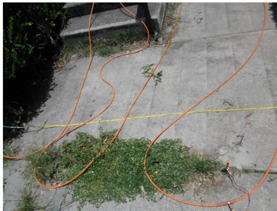
Figura 13. Fotografía donde se observan electrodos colocados en contacto con el terreno (19.5084° N, 99.1564° W. Calle: Telecomunicaciones).
