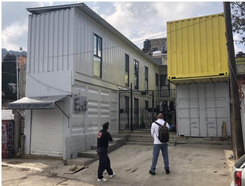
Imagen 31 En algunas viviendas con pérdida total se optó por otro tipo de materiales, en este caso acero de contenedores habilitados para vivienda.
