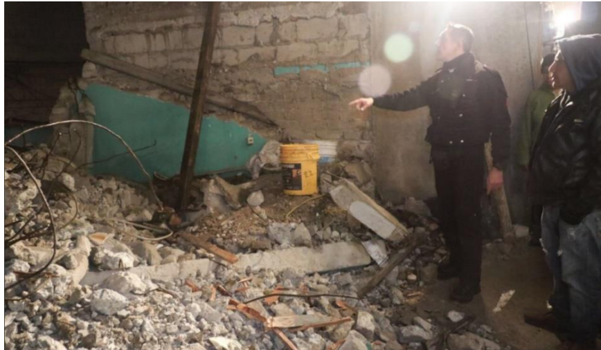
Imagen 2 Afectaciones en San Pablo Chimalpa derivados del sismo del 19 de septiembre de 2017
