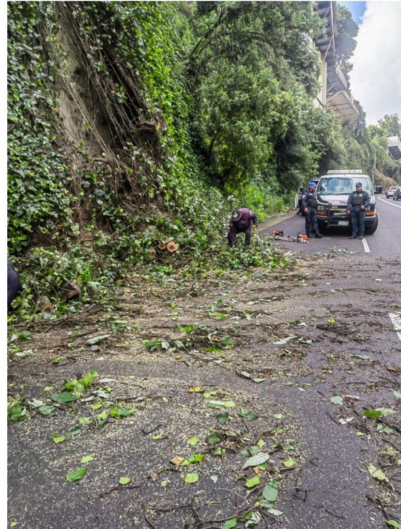
Mitigación de riesgo por deslizamiento de laderas 2025.
