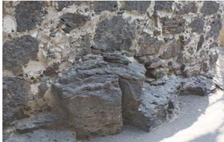
Ilustración 108. Construcción cimentada sobre la roca madre. Barrio La Candelaria.
