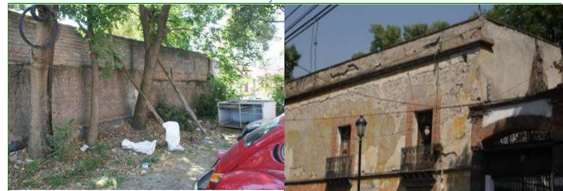
Ilustración 104. Construcciones de adobe cimentada en roca basáltica. Barrio La Retama centro de Coyoacán.
