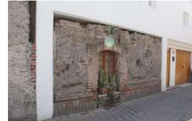
Ilustración 109. Vivienda con sistemas constructivos mixtos que aumentan la calidad estructural respetando el valor patrimonial en el cuadrante de San Francisco.
