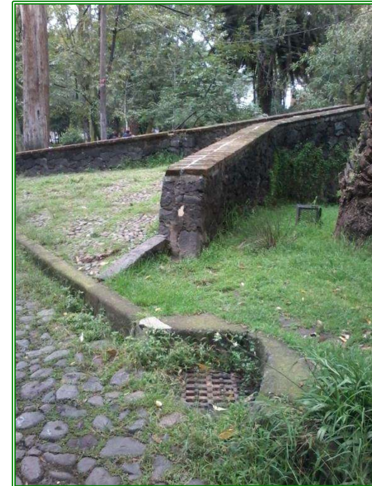
Ilustración 11. Puente en la calle Paseo del Río, por debajo corre entubado el río Magdalena.
