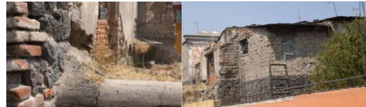
Ilustración 107. Construcción de adobe y roca basáltica. Barrio La Candelaria.
