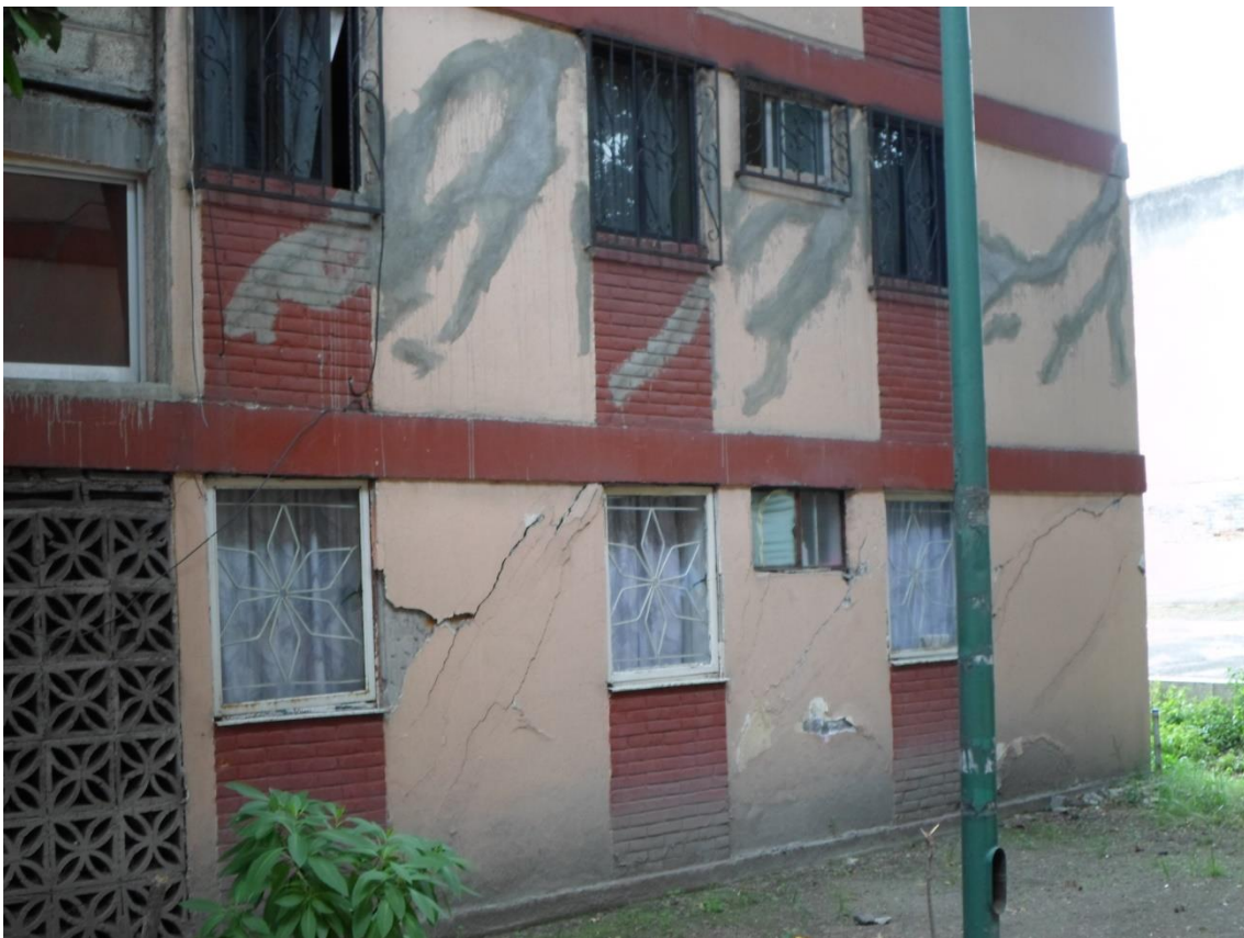
Figura. Grieta diagonal en muro interior de vivienda la cual parte de la zona superior del castillo hacia el nivel de piso con una abertura considerable (19.4849° N; 99.1733° W. Calle: Soledad).
