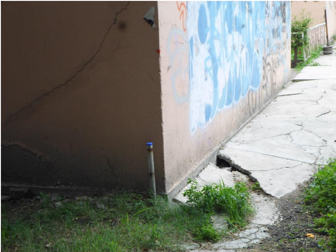
Figura 5. Fracturas similares en muros sobre el mismo eje, las cuales se observan bajo las ventanas, que se presentaron debido a que estas no se encuentran confinadas (19.4849° N; 99.1733° W. Calle: Soledad).
