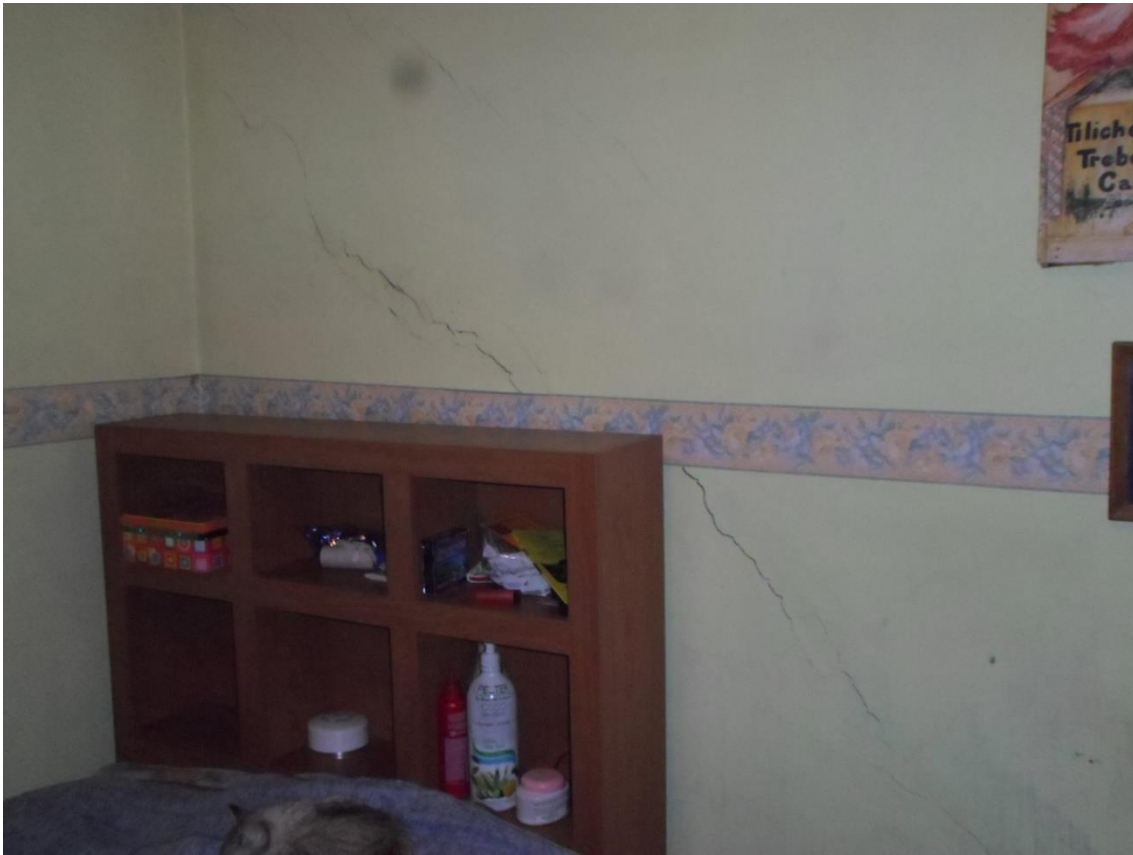
Figura. Grieta diagonal en muro interior de vivienda la cual parte de la zona superior del castillo hacia el nivel de piso con una abertura considerable (19.4849° N; 99.1733° W. Calle: Soledad).
