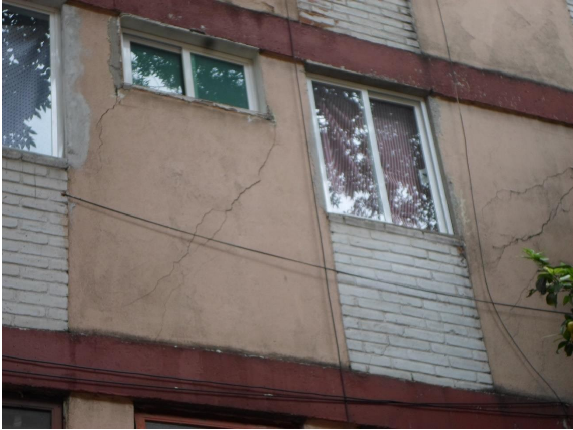
Figura 5. Fracturas similares en muros sobre el mismo eje, las cuales se observan bajo las ventanas, que se presentaron debido a que estas no se encuentran confinadas (19.4849° N; 99.1733° W. Calle: Soledad).
