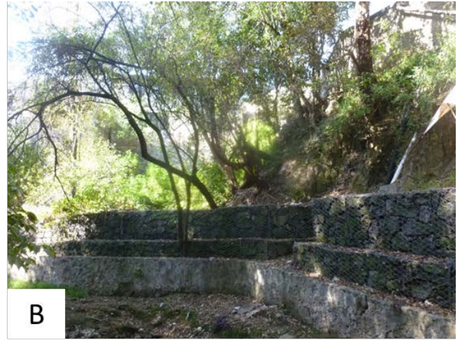
Figura 5. Se observan obras de mitigación. A) Muro de contención hecho con costales rellenos de material fino, los materiales contenidos se saturan de agua y rompen el saco que los contiene, sumando material fino que puede arrastrarse hacia la parte baja de la barranca. B) Muro de mampostería adherido con mortero (base), y muro de gaviones de 2.30 m de altura, esta obra de contención permite el paso del agua, impidiendo que el material arenoso se vaya hacia las partes más bajas (19.3205° N, 99.2643° W. Calle: Emiliano Zapata).
