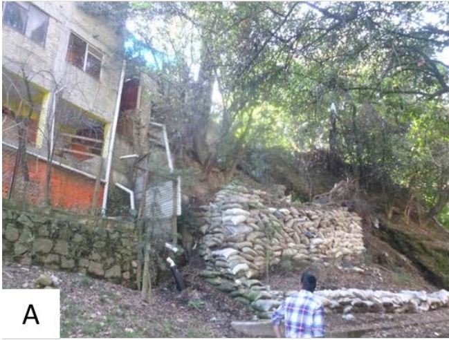
Figura 5. Se observan obras de mitigación. A) Muro de contención hecho con costales rellenos de material fino, los materiales contenidos se saturan de agua y rompen el saco que los contiene, sumando material fino que puede arrastrarse hacia la parte baja de la barranca. B) Muro de mampostería adherido con mortero (base), y muro de gaviones de 2.30 m de altura, esta obra de contención permite el paso del agua, impidiendo que el material arenoso se vaya hacia las partes más bajas (19.3205° N, 99.2643° W. Calle: Emiliano Zapata).
