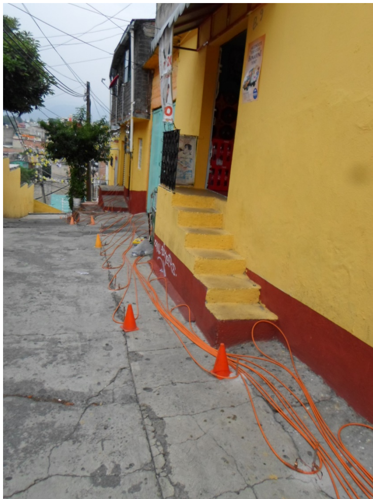
Figura 9. Se muestra el tendido del cable sobre la calle durante el levantamiento (19.3815° N; 99.2462° W. Calle: Asperillas).
