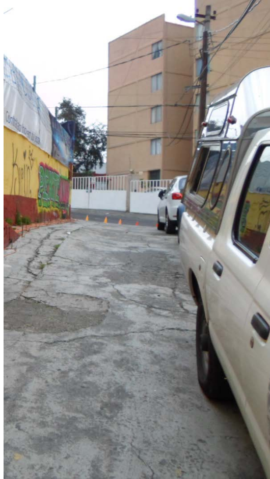
Figura 3. Se muestra una estructura de relleno sobre la calle (19.3481° N; 99.2284° W. Calle: Asperillas).
