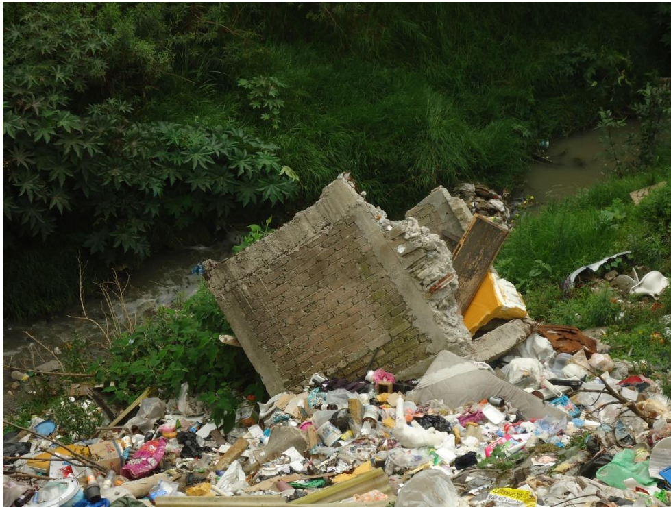
Figura 21. Pared de barranca con gran pendiente, la cual presenta residuos sólidos urbanos, además de un fragmento de construcción que se desprendió quedando sobre el piedemonte (19.3569° N, 99.2164° W. Calle: Tarango).
