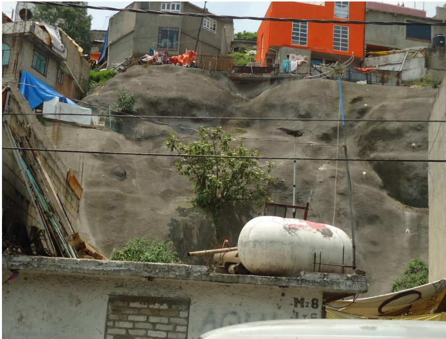
Figura 5. Se observa un muro de concreto lanzado como obra de mitigación (19.3569° N, 99.2163° W. Calle: Tarango).
