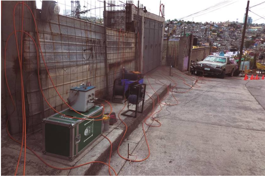
Figura 8. Localización del instrumento SYSCAL PRO y el tendido del cable durante el levantamiento de la TRE (19.3779° N; 99.2336° W. Calle: Paseo Lomas de Jalalpa).
