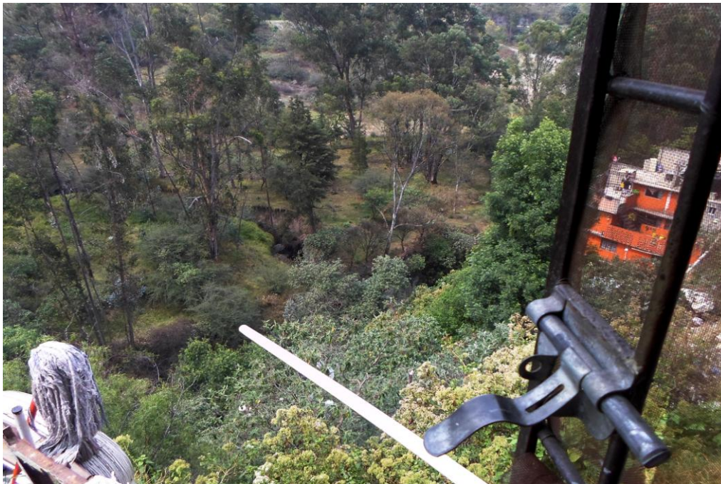
Figura 20. Pared de barranca donde se observa un tubo de drenaje que deposita su contenido en las paredes de la misma, este tipo de acciones fomenta el arrastre de los materiales que constituyen los taludes de las barrancas (19.3783° N, 99.2337° W. Calle: Barranca La Morena).
