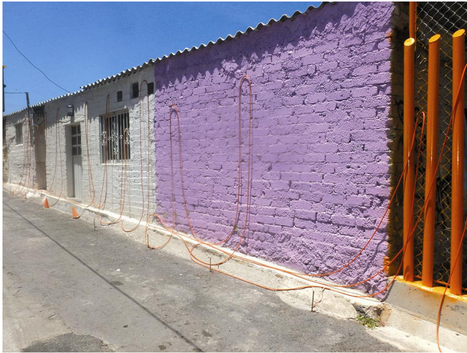
Figura 10. Imagen que muestra los electrodos y el tendido del cable sobre la cual se realizó el estudio (19.3814° N, 99.2463° W. Calle: Barranca La Morena).
