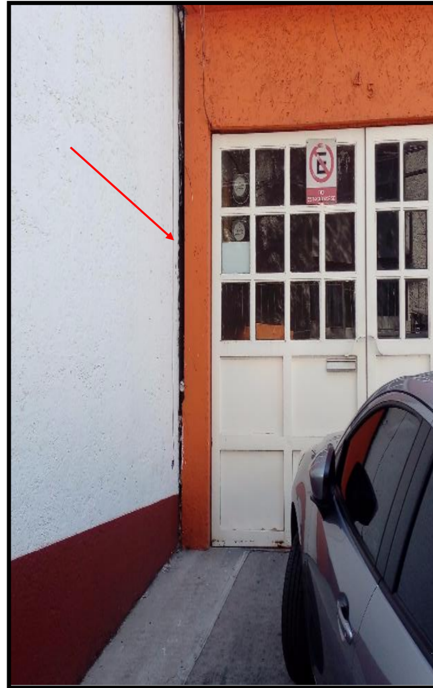
Coordenadas UTM 14Q 481422.3142 2150871.078 Geográficas 19 ° 27 ' 6.98 " -99 ° 10 ' 37.15 " Ubicación Calle Cañitas, Popotla Observaciones Separación entre las casas
