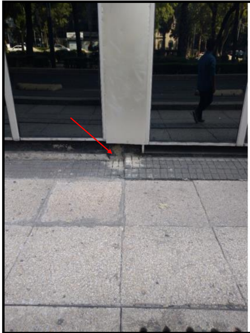
UTM Geográficas Coordenadas 2147959.55 m N 482307.30 m E N 19.425877° O 99.168535° Ubicación Calle. Varsovia. Col. Juárez Observación Hundimiento
